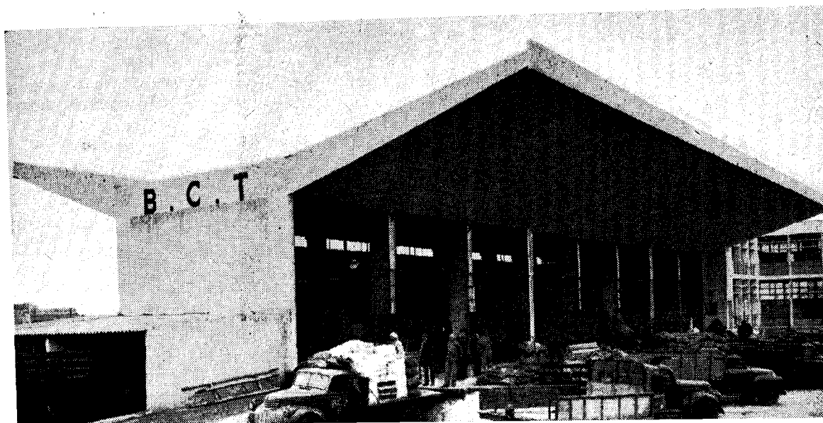
Gare routière B.C.T. de Casa- blanca. (Vue sur l'un des quais de charge- ment et sur ma- gasins).
