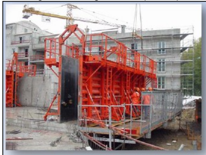
Figure 61 : Coffrage des voiles (banches)
