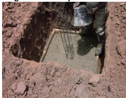
Figure 46 : Puits pour fondation
