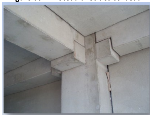
Figure 60 Poteau avec des corbeaux
