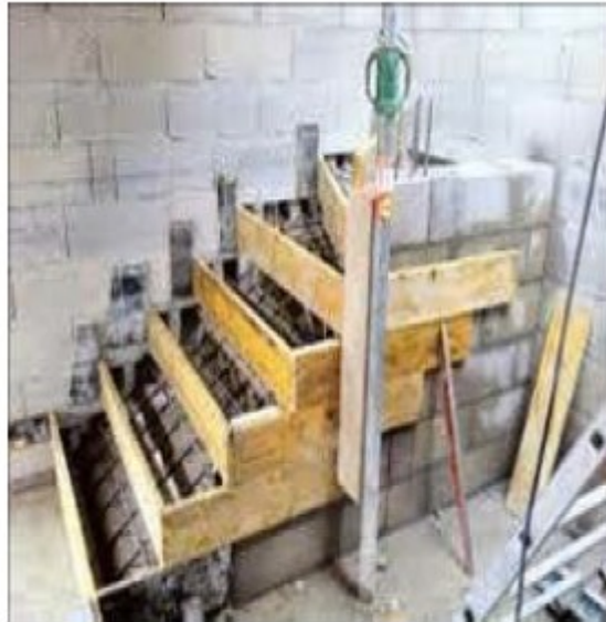
Figure 83 : Escaliers en béton coulés en place
