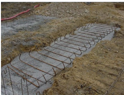
Figure 55 : Mise en place des armatures d'une semelle filante
