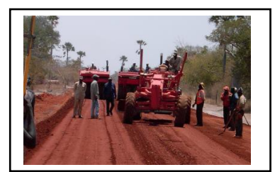
Figure 49 : Une niveleuse et un compacteur
