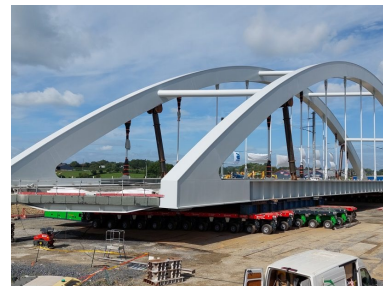
Pont ferroviaire « bow string » d'Avesnelles (59) – Crédit photo : Berthold SA - scmf
