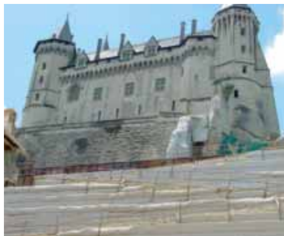
Chantier ROCK PEC
