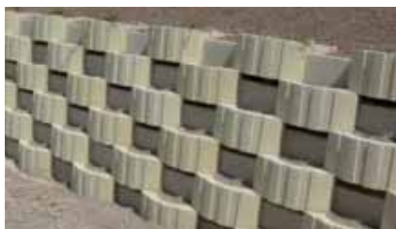
Chantier Taluroc crème
