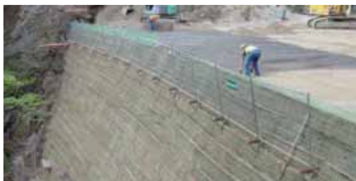
Chantier MIRAGRID GX
