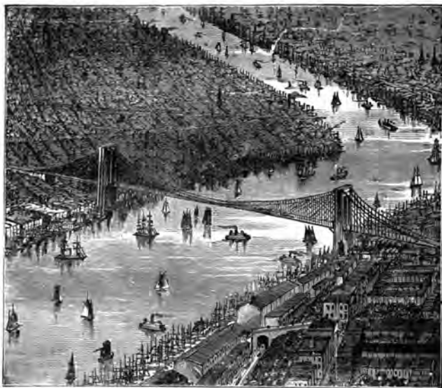
Un puente suspendido.
